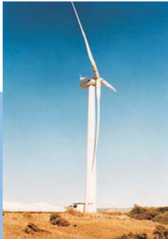
Instalación de cableado subterráneo de Media y Baja Tensión e interconexión de Centros de Transformación en Parque Eólico en Tarifa (Cádiz)
