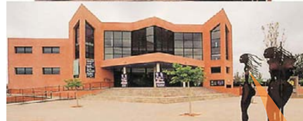
Instalación de Zonas Técnicas y Sonido del Auditorio Samaniga-Cala Millor en Palma de Mallorca
