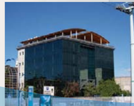
Edificio Cambalache ZZJ & DTM Isla de La Cartuja (Sevilla)
