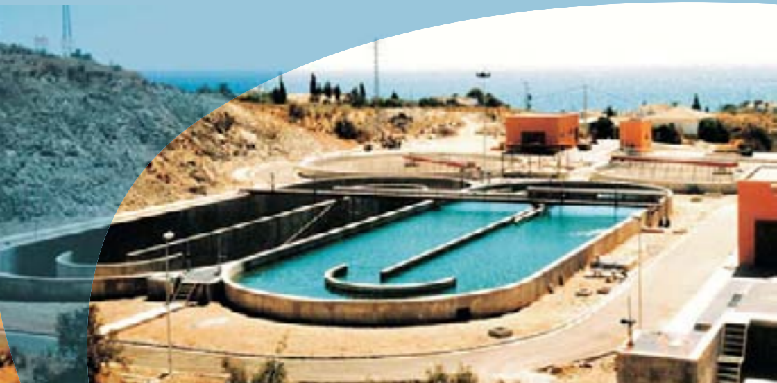
Estación recuperadora de Aguas Residuales de Lluçmajor
