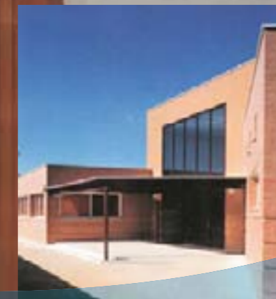
Instalación Eléctrica en Baja Tensión de Instituto de Enseñanza Secundaria de La Luisiana (Sevilla)
