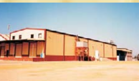
Montaje de media y baja tensión, en fábrica de zumos Los Mimbrales en Almonte (Huelva)
